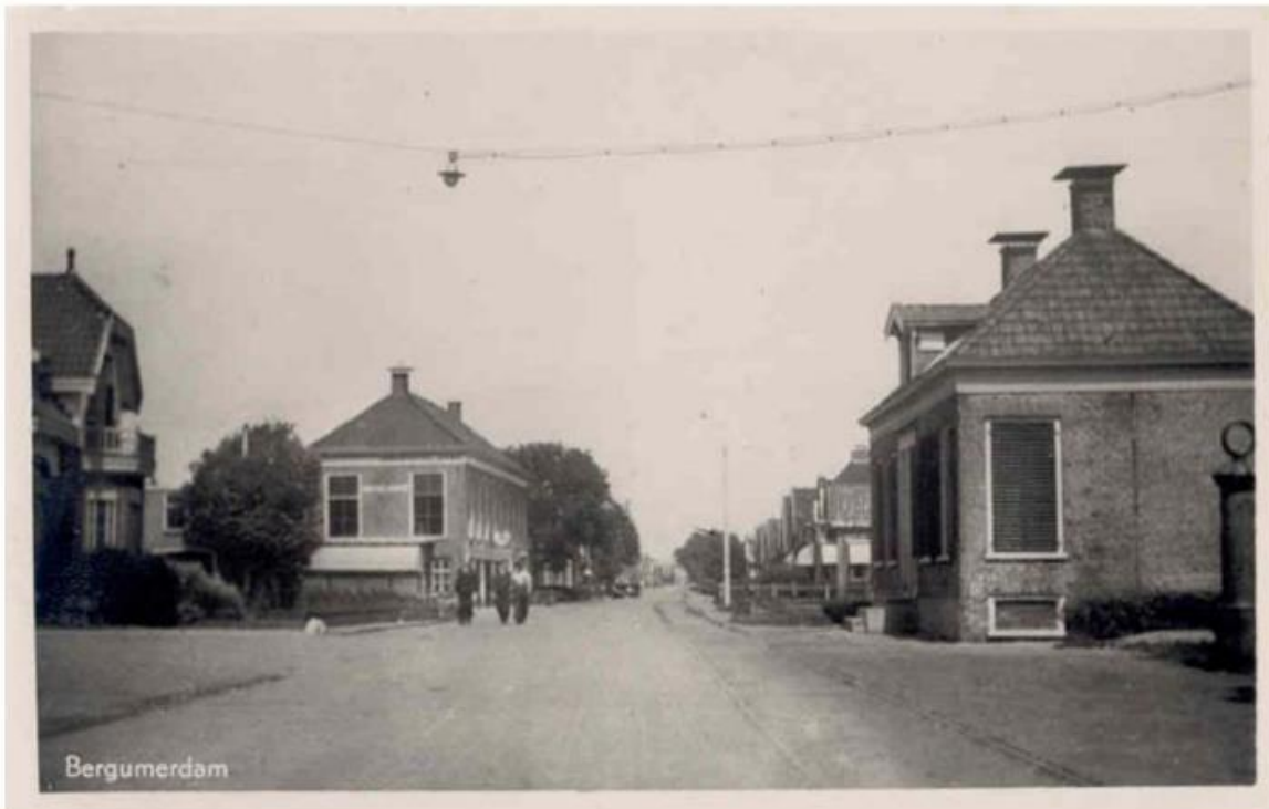
It grutte hûs foar de direksjewente tsjinoer it fabryk. Nei de Kolkbrêge kafee "De Bearzen". Rjochts de tram rails.
